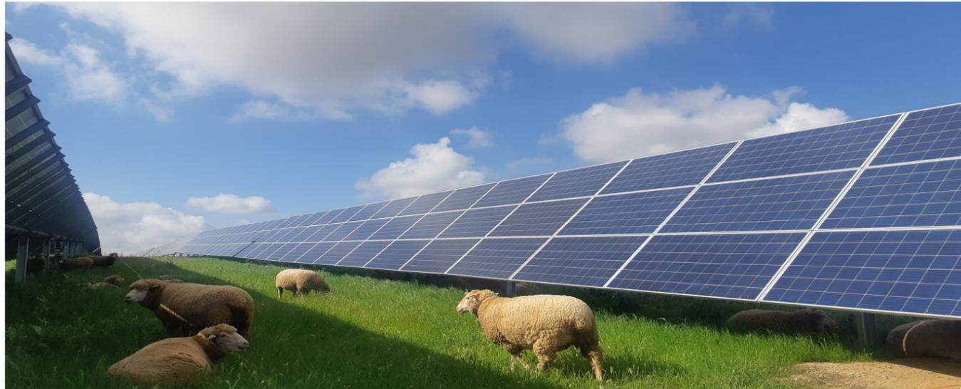
300MWの太陽光発電システムと561MWhの蓄電池システムで構成されるスレート・プロジェクト（米国）
