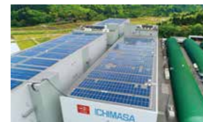
新潟県阿賀野市 867 kW 2022年
