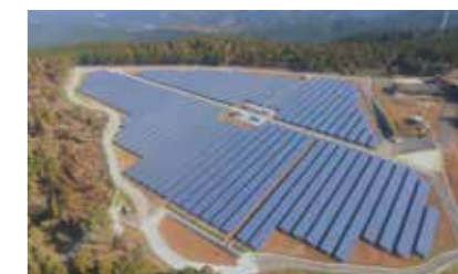
熊本県葦北郡 2.3 MW 2015年
