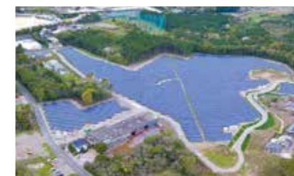
長崎県南島原市 4 MW 2016年
