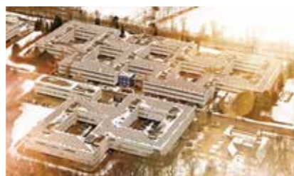
デンマーク 0.89 MW 2018年
