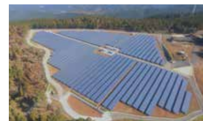
熊本県葦北郡 2.3 MW 2015年
