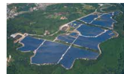
熊本県益城郡 47 MW 2017年
