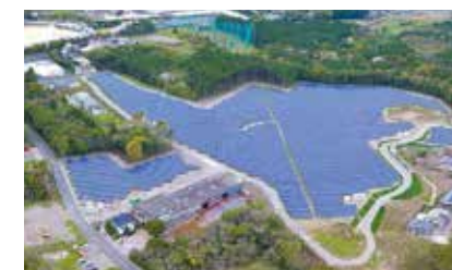
長崎県南島原市 4 MW 2016年
