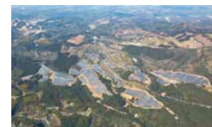
大分県速見郡日出町 53.4 MW 2019年
