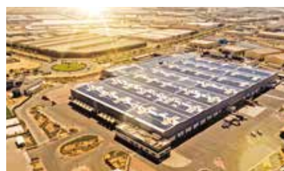
ドバイ 3.77 MW 2019年
