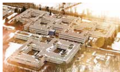
デンマーク 0.89 MW 2018年
