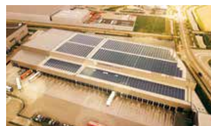
オランダ 0.987 MW 2018年
