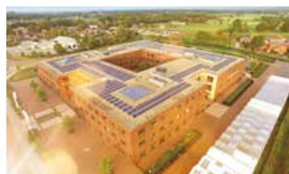
オランダ 0.523 MW 2015年
