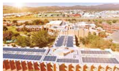
南アフリカ 0.89 MW 2018年
