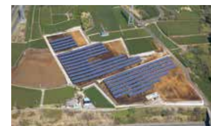
静岡県沼津市 1 MW 2018年
