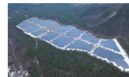
鳥取県西伯郡 27.3 MW 2017年
