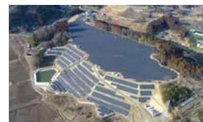
宮城県大河原町 7.5 MW 2020年
