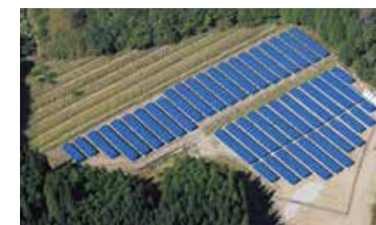
兵庫県朝来市 652.8 kW 2014年
