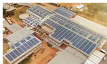
南アフリカ 1 MW 2019年
