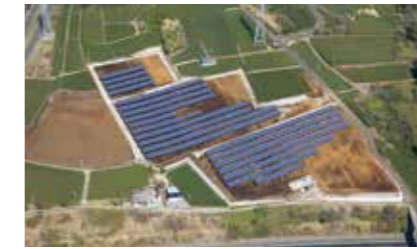
沼津石川発電所(静岡県沼津市) 1 MW 2018年
