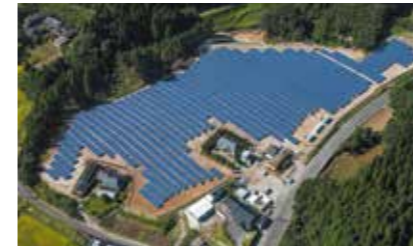
木場発電所(鹿児島県伊佐市) 2.2 MW 2015年
