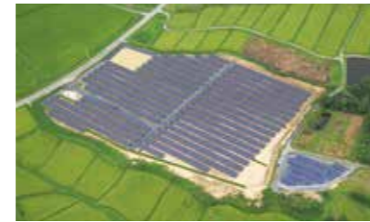
岩手花泉発電所(岩手県一関市) 1.48 MW 2017年
