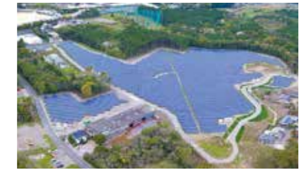
南島原発電所(長崎県南島原市) 4 MW 2016年
