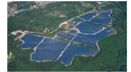
益城発電所(熊本県益城郡益城町) 47 MW 2017年
