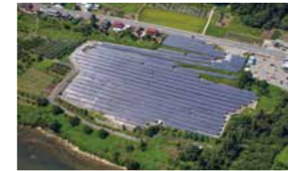
山形朝日町太陽光発電所(山形県西村山郡朝日町) 2.4 MW 2017年
