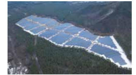
鳥取大山太陽光発電所(鳥取県西伯郡大山町) 27.3 MW 2017年
