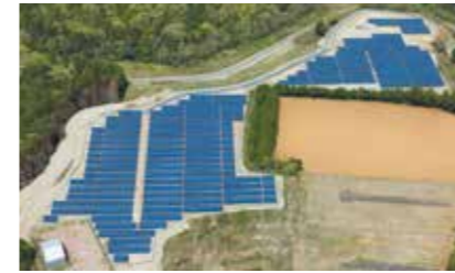
茨城県鹿嶋市 1.5 MW 2015年
