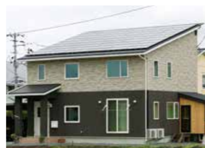
■ 岩手県盛岡市 根田様邸 ■ 12.15 kW システム
