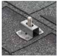
アスファルトシングル屋根
