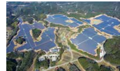
山口県美祢市 56.34 MW 2018年
