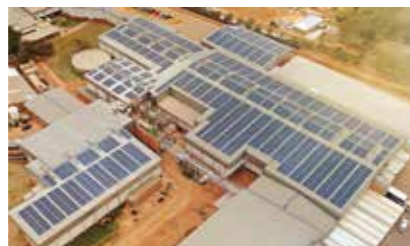
南アフリカ 1 MW 2019年
