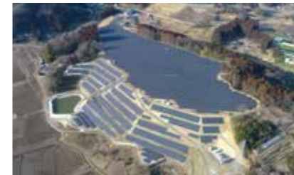
宮城県大河原町 7.5 MW 2020年
