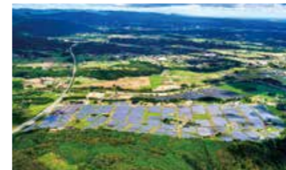
福岡県双葉町浪江町 60.192 MW 2019年
