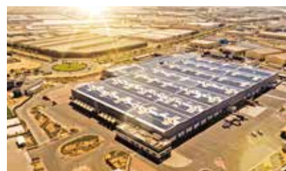
ドバイ 3.77 MW 2019年
