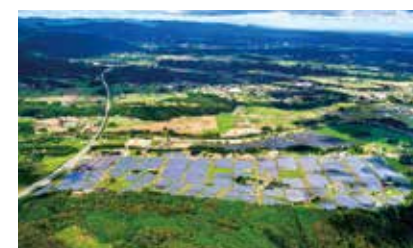
福岡県双葉町浪江町 60.192 MW 2019年
