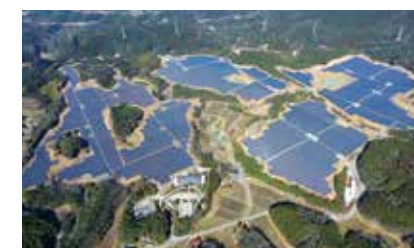
山口県美祿市 56.34 MW 2018年
