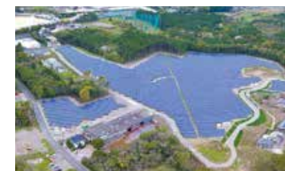
長崎県南島原市 4 MW 2016年
