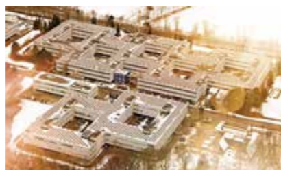
デンマーク 0.89 MW 2018年
