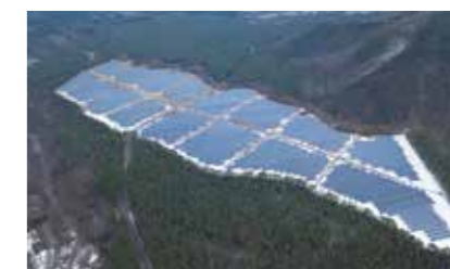
鳥取県西伯郡 27.3 MW 2017年
