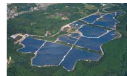
熊本県益城郡 47 MW 2017年
