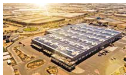
ドバイ 3.77 MW 2019年
