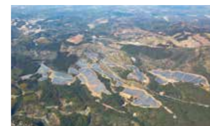
大分県速見郡日出町 53.4 MW 2019年
